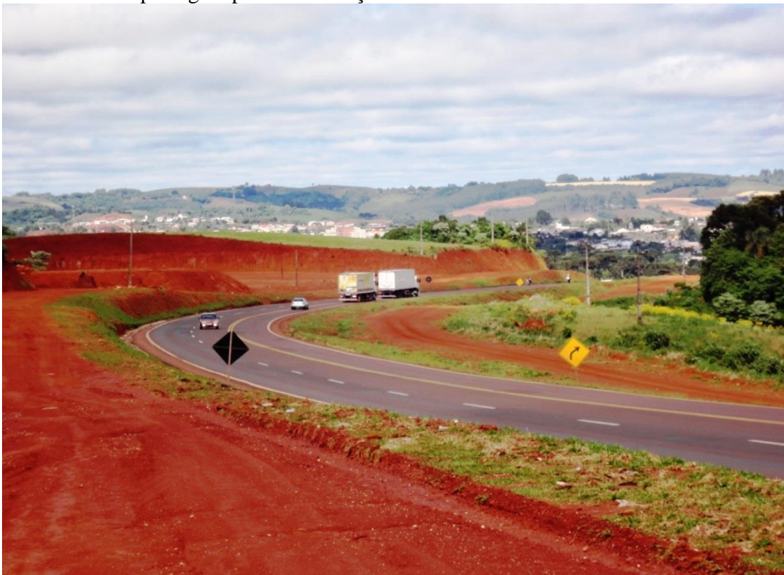
Foto 05 – Terraplenagem para a construção de loteamentos.
