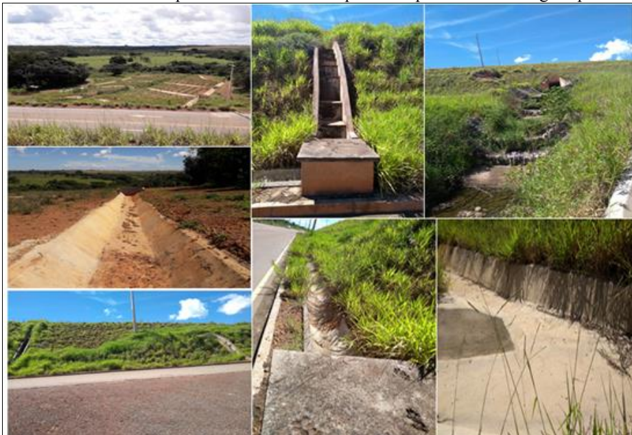
Figura 6 - Vista da erosão 1 recuperada e infraestrutura para disciplinamento das águas pluviais.
