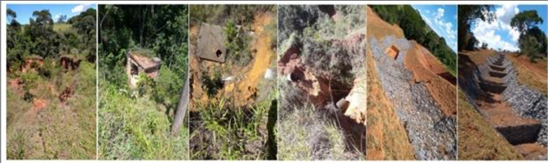
Figura 7 - Vista da erosão 2 com trechos degradados e em recuperação.
