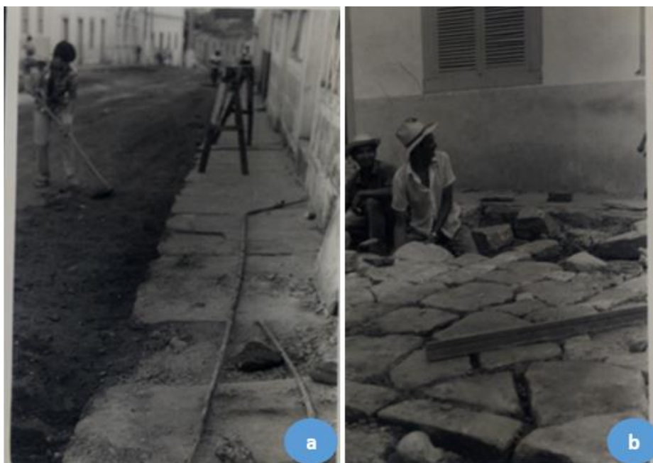
Figura 03 - Remoção de calçamento do centro histórico para melhorias na infraestrutura - (a) remoção do calçamento para a passagem de encanamentos e (b) calceteiros.
