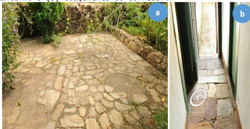
Figura 07 - Imagens da parte interna do Museu Cora Coralina - (a) calçamento do pátio interno e (b) calçamento do corredor.
