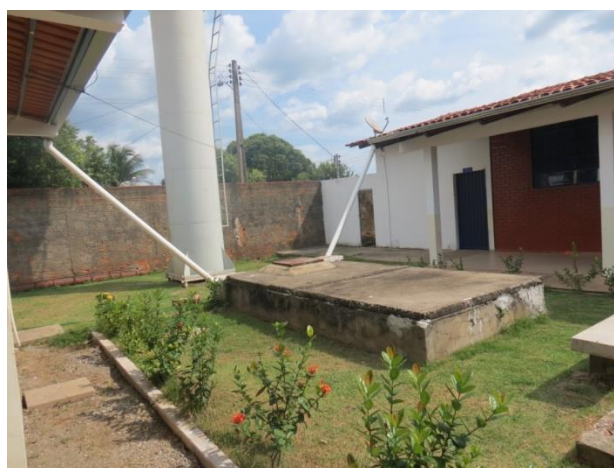
Figura 2: Captação de água da chuva utilizada nos serviços de limpeza da escola
