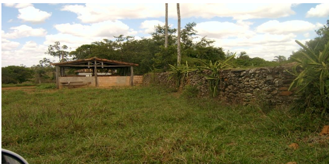
Foto 03 - Muros de pedra, construídos pelos escravos, no Assentamento São Sebastião. Arquivo particular da autora - outubro/2009.
