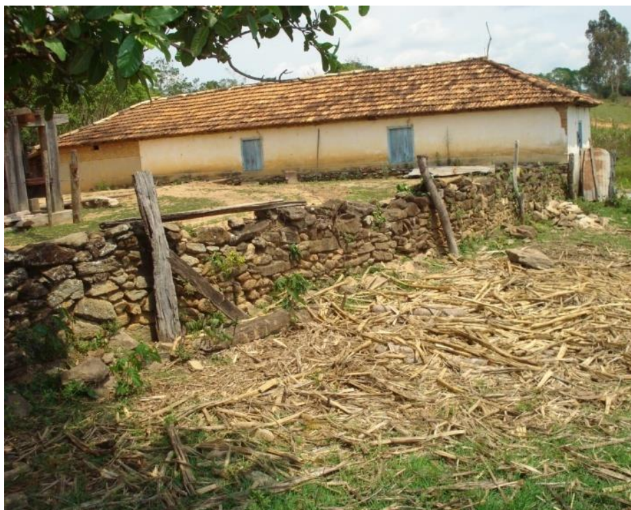
Foto 04: Muros de Pedra construído pelos escravos na fazenda do Sr. Erlindo Almeida Barbosa, em São Sebastião da Garganta. Arquivo pessoal da pesquisadora, tiradas em fevereiro de 2009.
