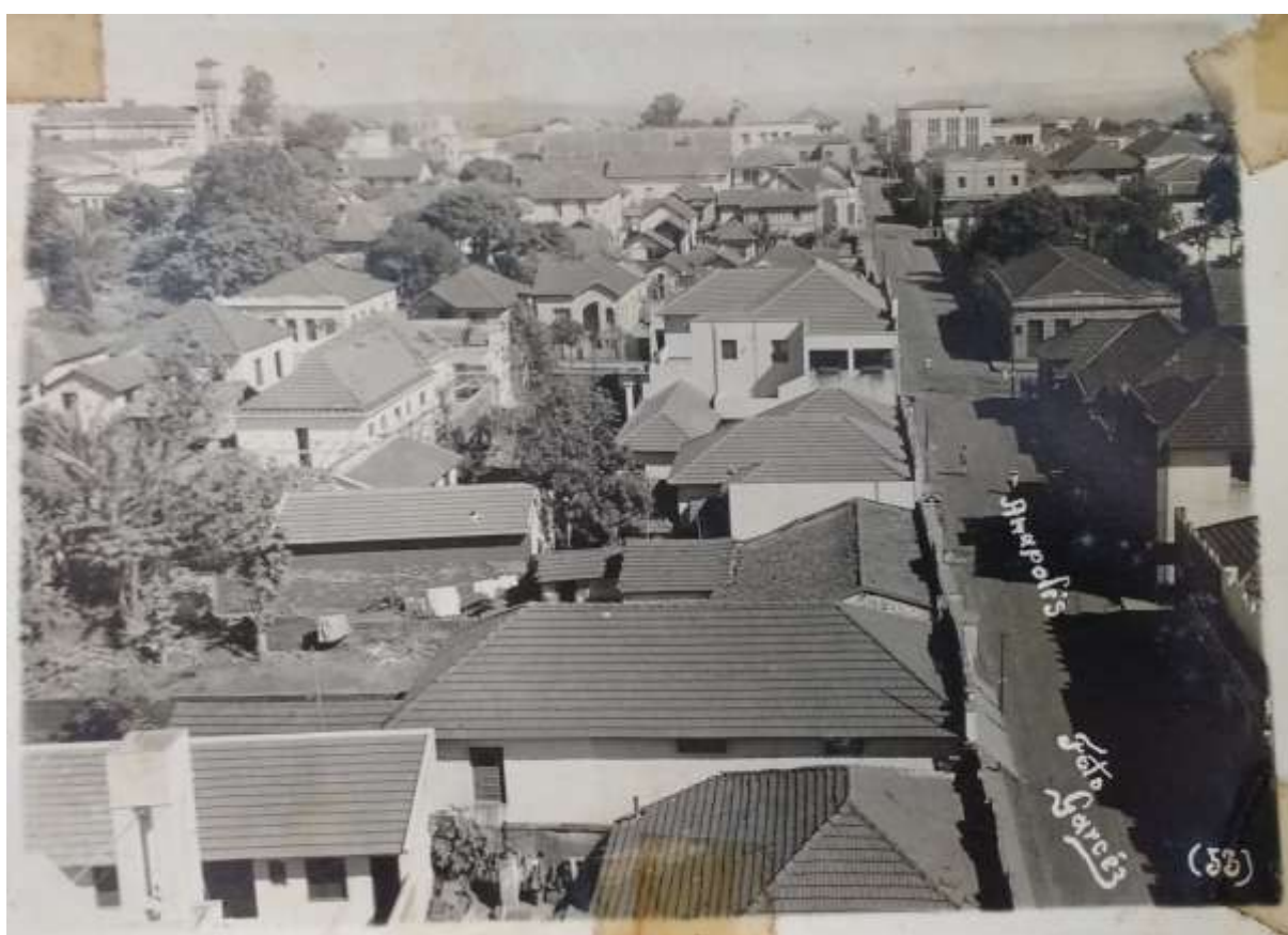
Vista dos telhados de várias casas próximas à Avenida Barão Rio do Branco
