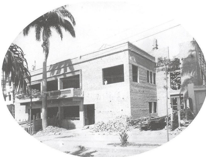
Figura 06 - Construção do Cine-Teatro Cuiabá, 1941. Fonte: SIQUEIRA, 2006.
