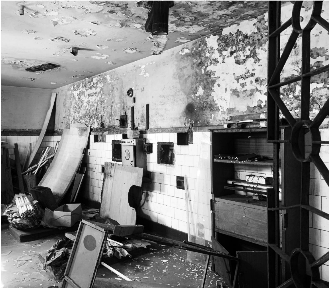
Figura 14: Destroços da modernidade. Vista do interior da câmara de projeção do Cine Teatro Santana, abril de 2024. Autora: Maíra Teixeira Pereira.
