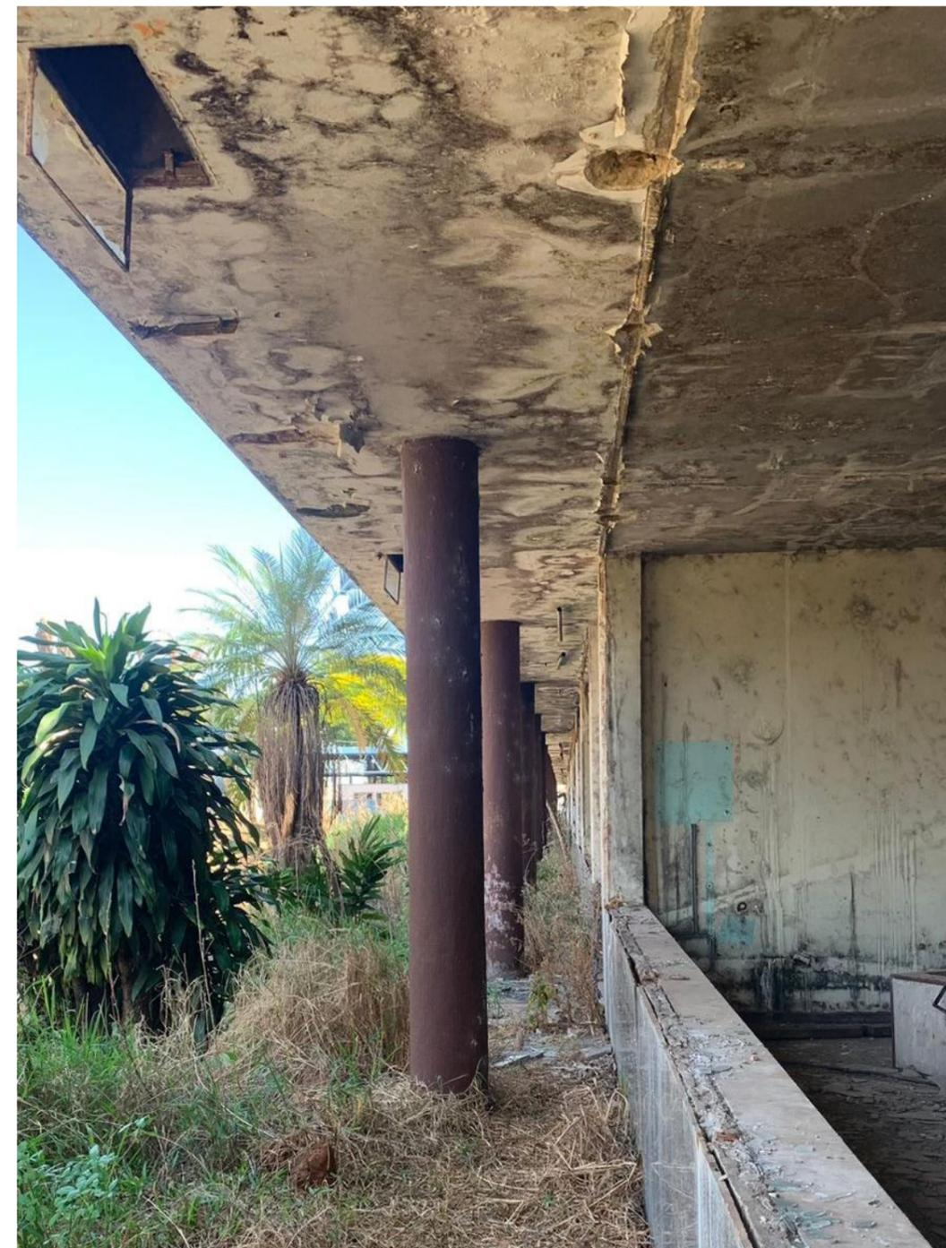
Figura 27. Estrutura garante planta e fachada livres: ditames modernos
