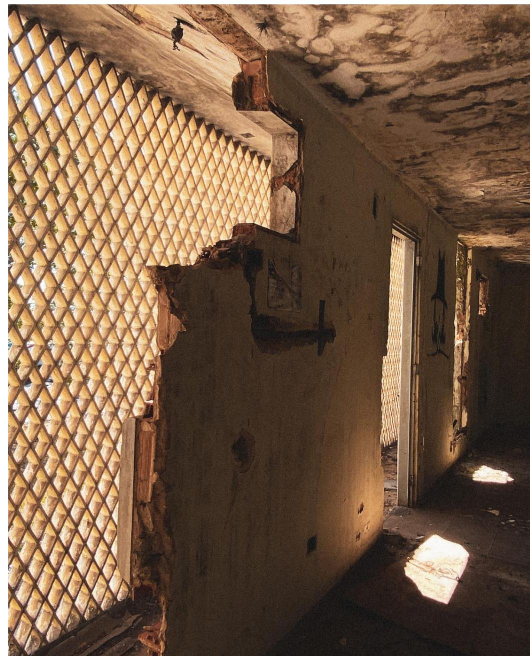
Figura 15. Interior das dependências do pavimento superior. Alvenaria e trama losangular de proteção solar
