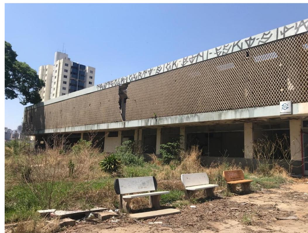
Figura 5. Reticula de malha losangular. Elemento de proteção de fachada
