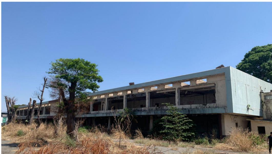
Figura 8. Plano da fachada sudeste do estacionamento. Vãos retangulares para ventilação sobre laje de cobertura.
