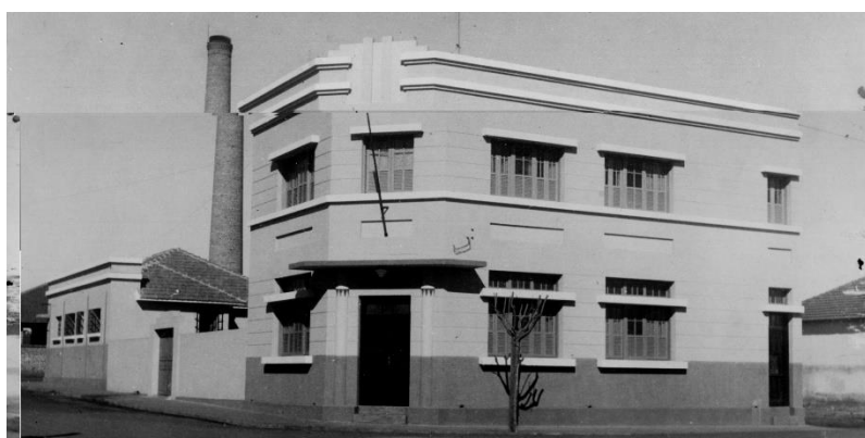
Construção de um novo edifício no local da antiga cadeia pública na Praça Joaquim Lúcio. Fonte: IBGE .
