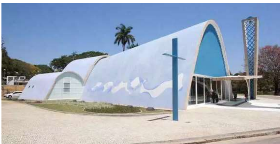
Figura 4 – Sistema Estrutural de superfície: Igreja da Pampulha, Belo Horizonte-MG. Fonte: Acervo pessoal dos autores (2016).
