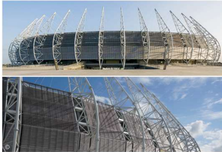
Figura 2 – Sistema Estrutural de vetor ativo: Arena Castelão, Fortaleza-CE. Fonte: Acervo pessoal dos autores (2018).
