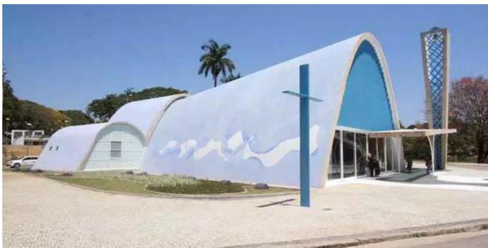
Figura 4 – Sistema Estrutural de superfície: Igreja da Pampulha, Belo Horizonte-MG.
