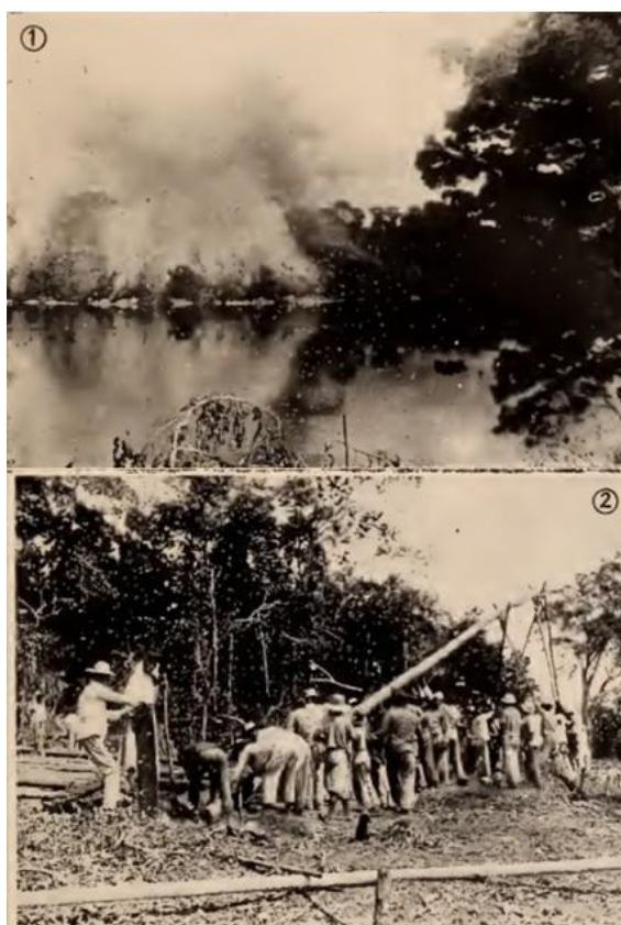
Figura 5 – Arriba la quema para instalar la misión. Abajo la construcción de la primera estructura de la iglesia.
