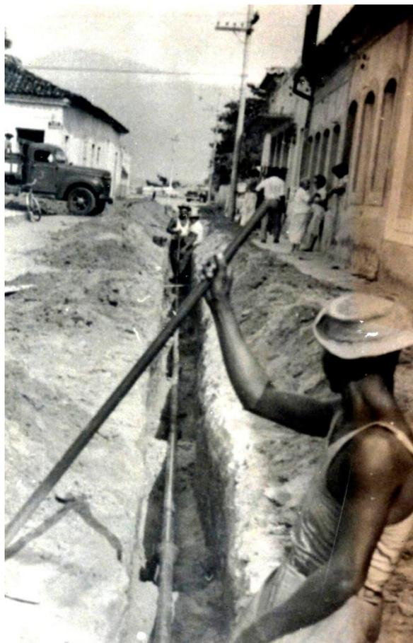
**Figura 01: Trabalhadores fazendo o encaixe dos canos para receber a camada de chumbo derretido.** O chumbo derretido era usado como vedação. Sistema de abastecimento de água: Centro de São Sebastião, SP. Década de 1960.
