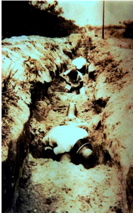
**Figura 02: Trabalhadores fazendo o encaixe dos canos para receber a camada de chumbo derretido.** O chumbo derretido era usado como vedação. Sistema de abastecimento de água: Centro de São Sebastião, SP. Década de 1960.
