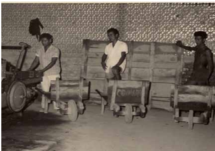
Foto 1 - Trabalhadores, com o manuseio de tijolos na máquina à vácuo. Fonte: Processo TRT - 24ª - Região - Corumbá MT (1968, p. 58).
