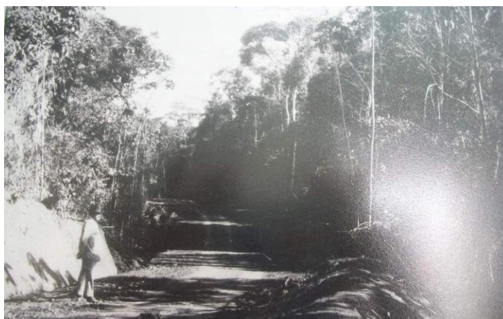
Figura 4: Construção da Estrada Ilhéus-Itabuna, 1926
