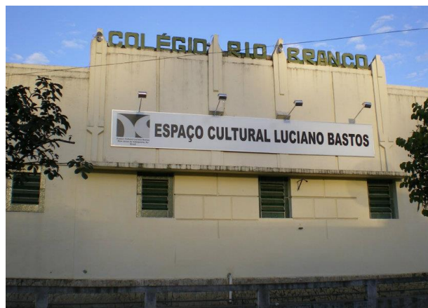
Fotografia 2: Prédio do CRB em 2011
