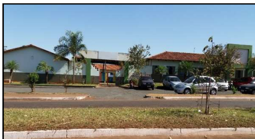
Figura 02 - Creche Municipal Nossa Senhora D’Abadia Fonte: SILVA, Priscila Vieira da, 2017.
