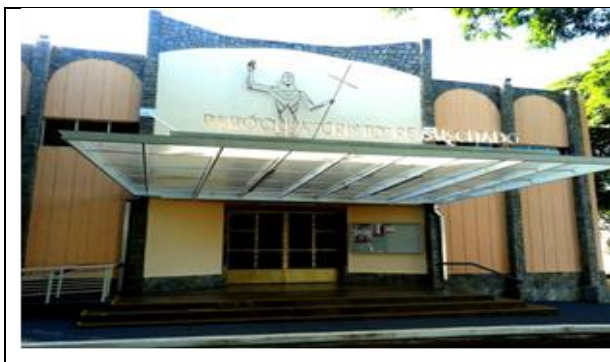
Figura 1: Paróquia Cristo Ressuscitado, Zona 5 Fonte: Os autores
