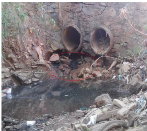
Figura 3: Brotamento da nascente abaixo da galeria pluvial Fonte: Autores, 2017
