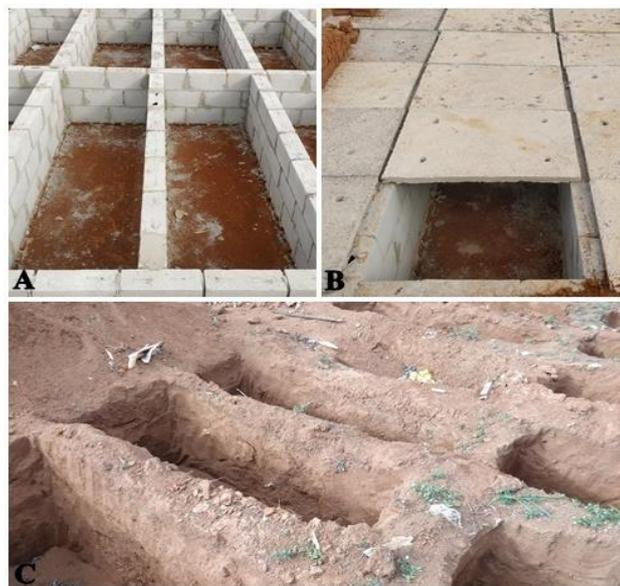
**Figura 9.** (A) Jazigos de alvenaria sem a tampa de concreto, (B) jazigos finalizados, (C) Covas para sepultamentos direto no solo.
