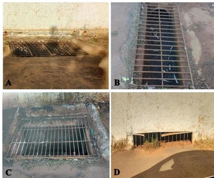
**Figura 7.** (A-C) Bocas de lobo com grelha para captação de águas pluviais no interior do cemitério, (D) Passagem com grade em muro de alvenaria para escoamento de águas pluviais.
