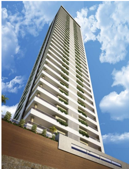
Figura 1 – Fachada do edifício. Fonte: Autores, 2017
