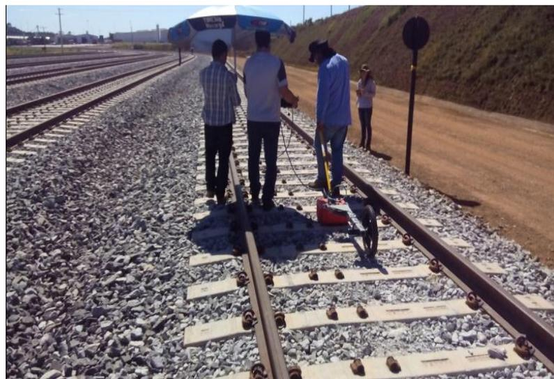
Figura 04 - Fotografia evidencia a aquisição de dados de GPR com o sistema SIR3000 acoplado a uma antena blindada de 900MHz.
