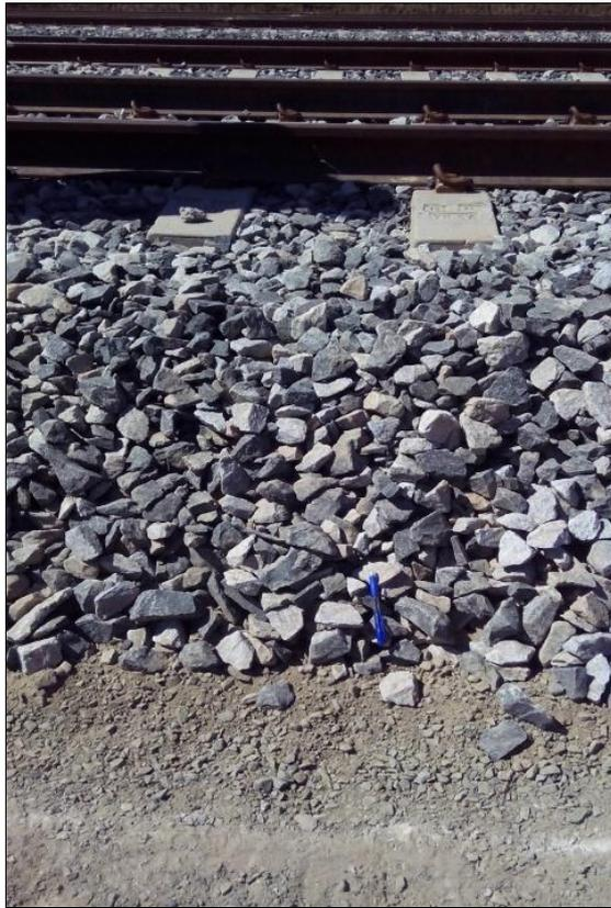
Figura 06 - Perfil esquemático do pavimento férreo, composto de dormentes/trilhos, camadas de lastro e sublastro, situado no pátio de manobras da ferrovia.
