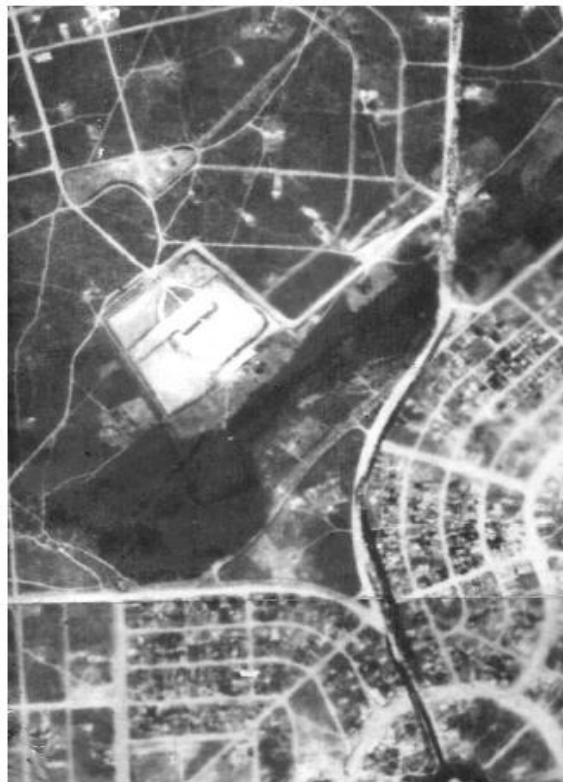
FIGURA 4 – Vista aérea do Parque Areião, década de 1960. Fonte: Prefeitura de Goiânia, 2004.
