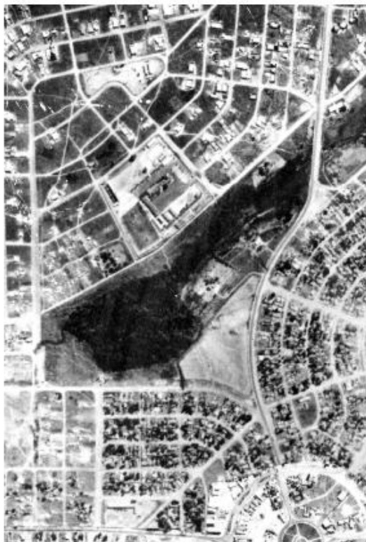
FIGURA 5 – Vista aérea do Parque Areião, década de 1970 Fonte: Prefeitura de Goiânia, 2004.
