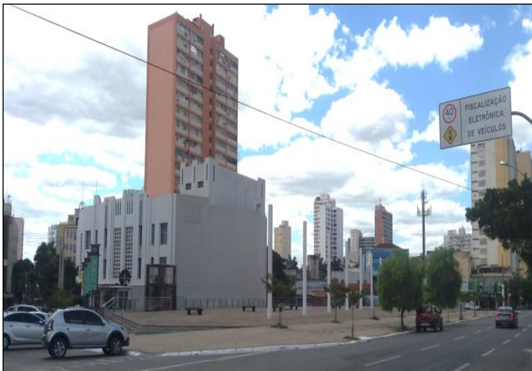
Figura 4 – Fotografia do projeto executado, denominado Vila Cultural Cora Coralina, vista da calçada do cruzamento da Rua 23 com a Rua 3. Fonte: Mayara Rezende, 2016.
