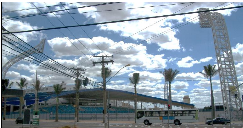
Figura 8 – Fotografia do projeto executado, denominado Centro de Excelência do Esporte. Fonte: Mayara Rezende, 2016.
