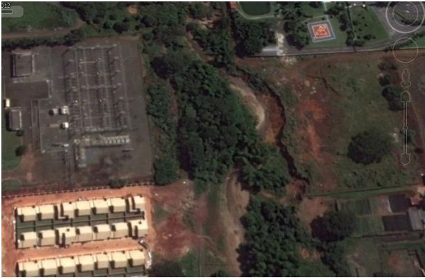
Figura 19 - Ausência de Mata Ciliar em trecho da bacia. Fonte: Google Earth, 2012.
