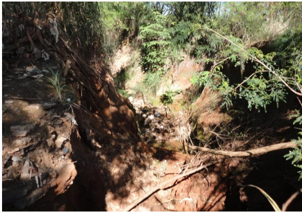
Figura 26 - Processos Erosivos. Fonte: Wesley Belizário, 2012.
