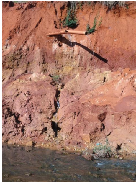
Figura 25 - Lançamento de Efluentes Industriais. Fonte: Wesley Belizário, 2012.
