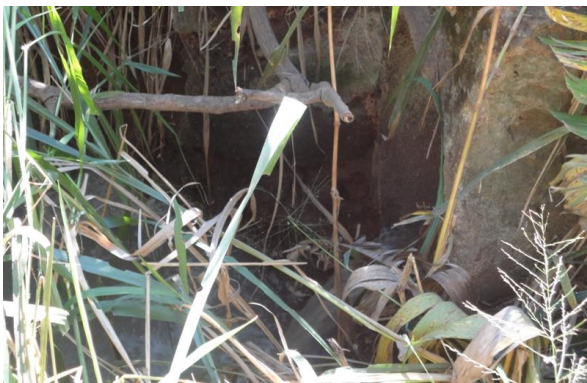
Figura 23 - Lançamento de Esgoto in natura . Fonte: Wesley Belizário, 2012.
