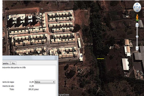
Figura 10 - Construções a menos de 30 metros do curso d'água. Fonte: Google Earth, 2012.
