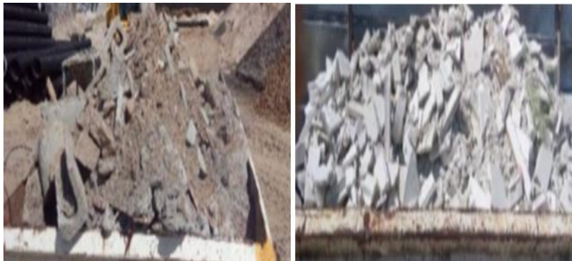
Figura 3 - Estoque do entulho de betão e areia.
