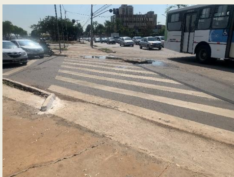
Figura 17: Falta de guia rebaixada para pedestres nas avenidas Goiás e Independência.
