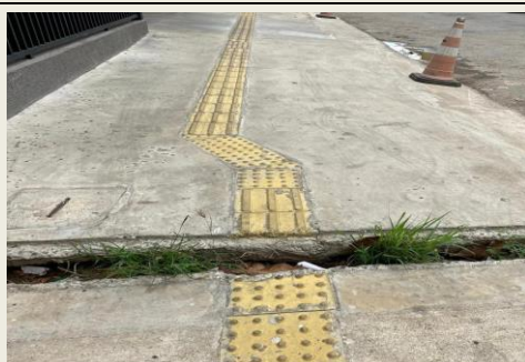
Figura 13: Problemas na execução do piso tátil
