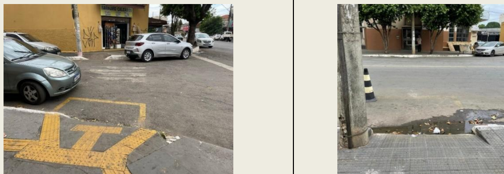
Figura 12: Guias de Rebaixo localizados na Rua 74.
