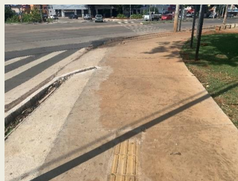
Figura 17: Falta de guia rebaixada para pedestres nas avenidas Goiás e Independência.
