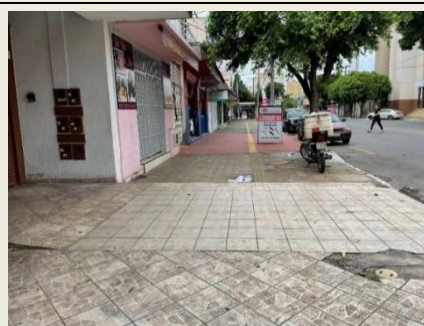
Figura 13: Problemas na execução do piso tátil
