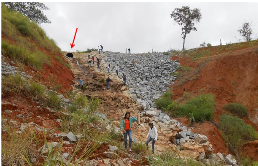
Figura 7. Intervenção na cabeceira da “Voçoroca da Ferrovia” e tubulação para escoamento de águas pluviais e de nascentes.
