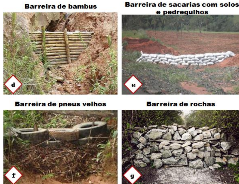
Figura 9. Técnicas de bioengenharia para conter erosão na área interna.
