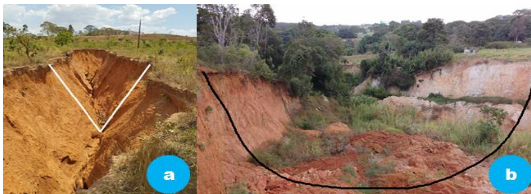
(a) “Ravina da Vaca Morta” junto à rodovia BR 060 em Anápolis / GO em 2022; (b) “Voçoroca dos Trilhos” junto à ferrovia em Anápolis / GO em 2017.
