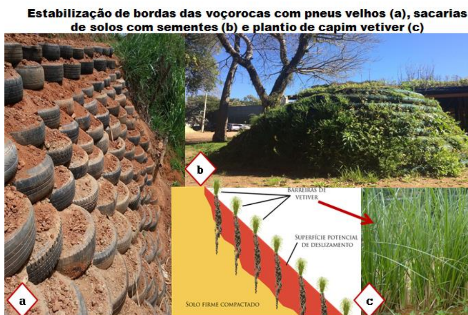
Figura 8. Técnicas de bioengenharia para estabilização de taludes.
