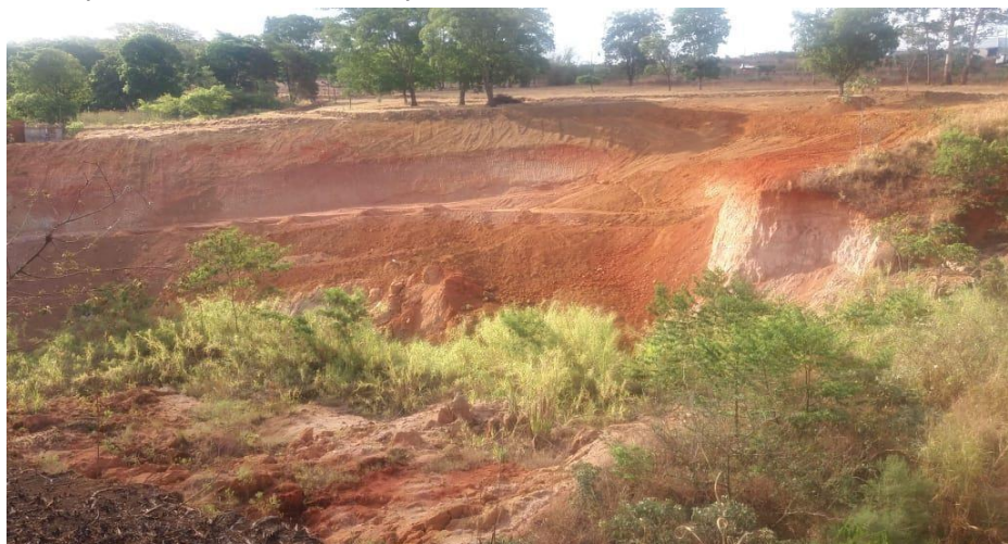
Figura 5. Intervenção na borda direita da “Voçoroca da Ferrovia”.
