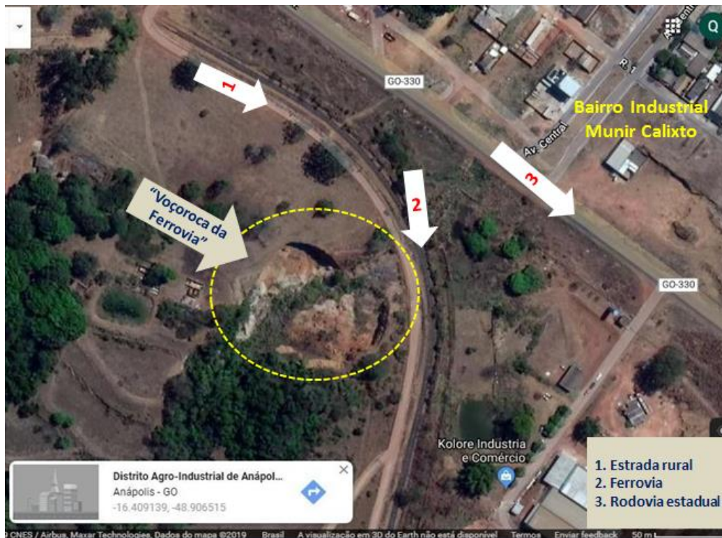
Figura 4. Vista da “Voçoroca da Ferrovia” nas proximidades do Bairro Industrial Munir Calixto.
