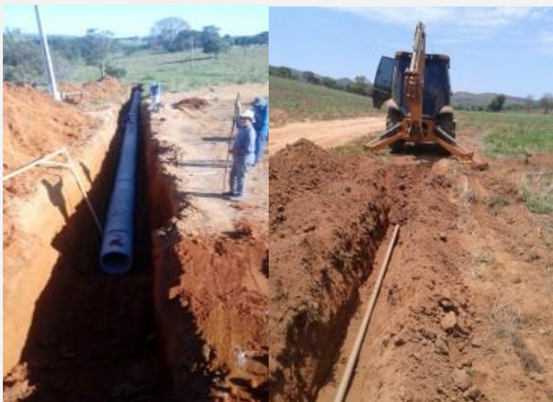
Figuras 9 e 10 - Instalação de galerias pluviais e rede de água potável. Fonte: El.Dorado (2017).
