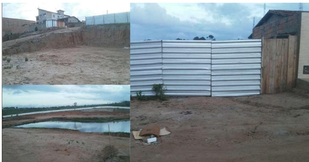
Figura 6. Fechamento, Intervenção e Realização das Obras. Fonte: SANTANA, 2017
