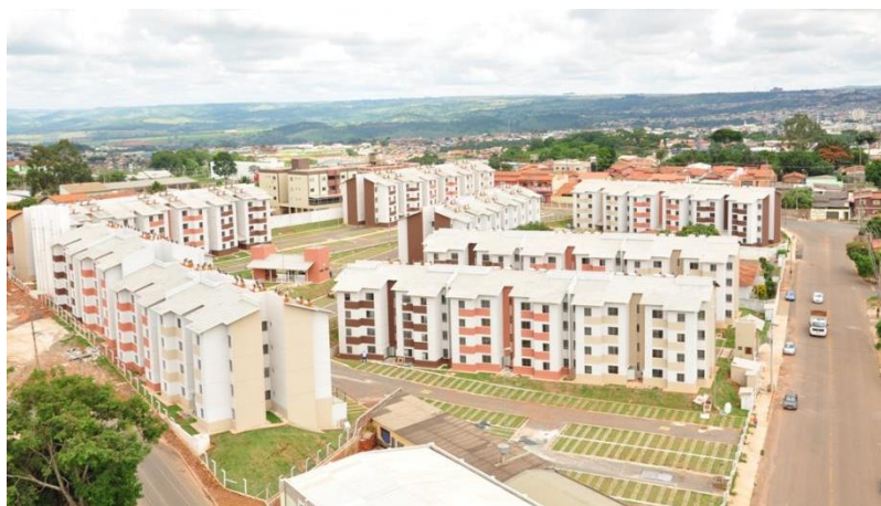
Figura 7 – Residencial Servidor e a sua inserção urbana em área consolidada
