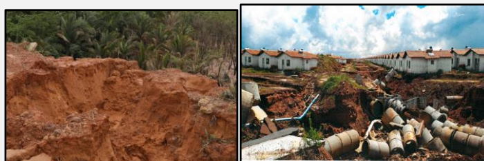
Figura 4 - Processos erosivos no Residencial Mato Grosso
