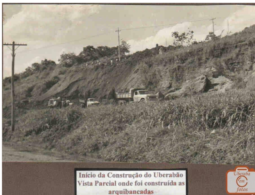
Figura 6: Obras da construção do Uberabão. Fonte: Jornal Lavoura e Comércio, 1962.
