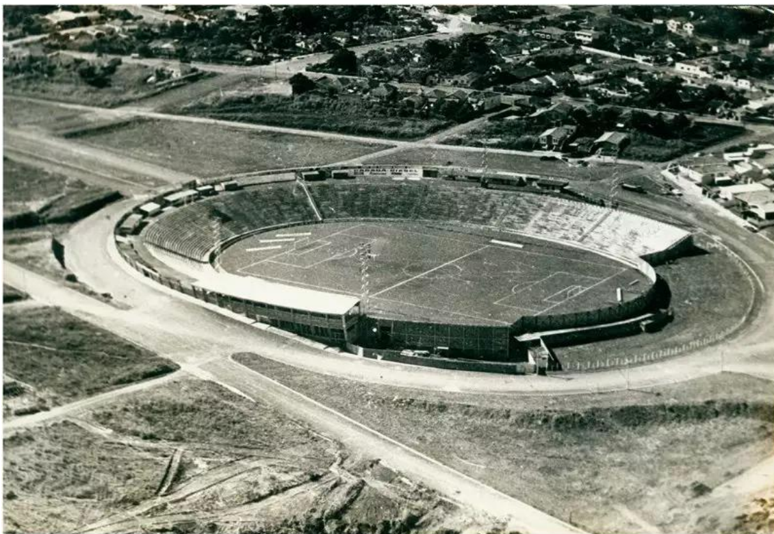
Figura 7: Uberabão na fase final de sua construção.
