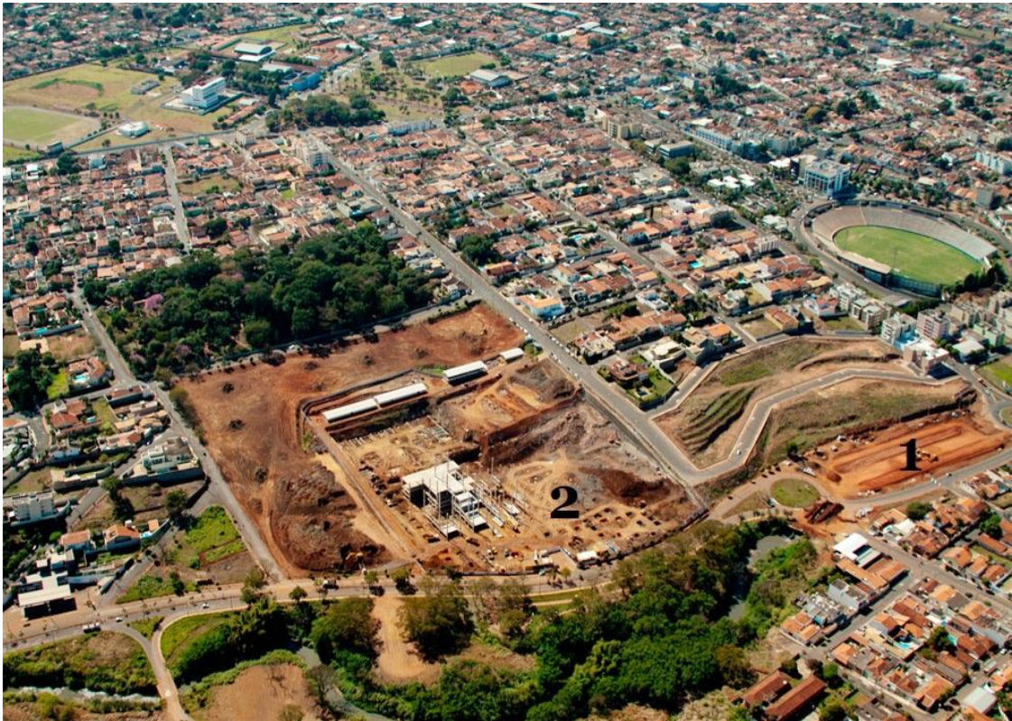
Figura 8: Processo de construção do Vetor/BRT (1) e do Praça Shopping (2), próximos ao Estádio. Fonte: Praça Shopping (Data aproximada: 2012).
