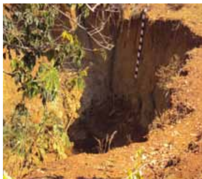
Figura 13: Voçoroca em margem de estrada. Autora: Maria da Penha R. O. Gomes.
