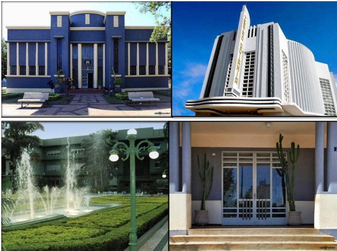
Figura 1: Exemplares de edificações em estilo art déco , Goiânia (GO).
